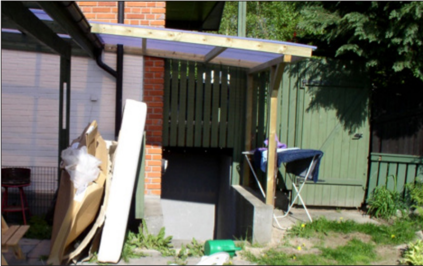
Figur 6-2 Taköverbyggd utvändig källartrappa. (Sweco 2003)
