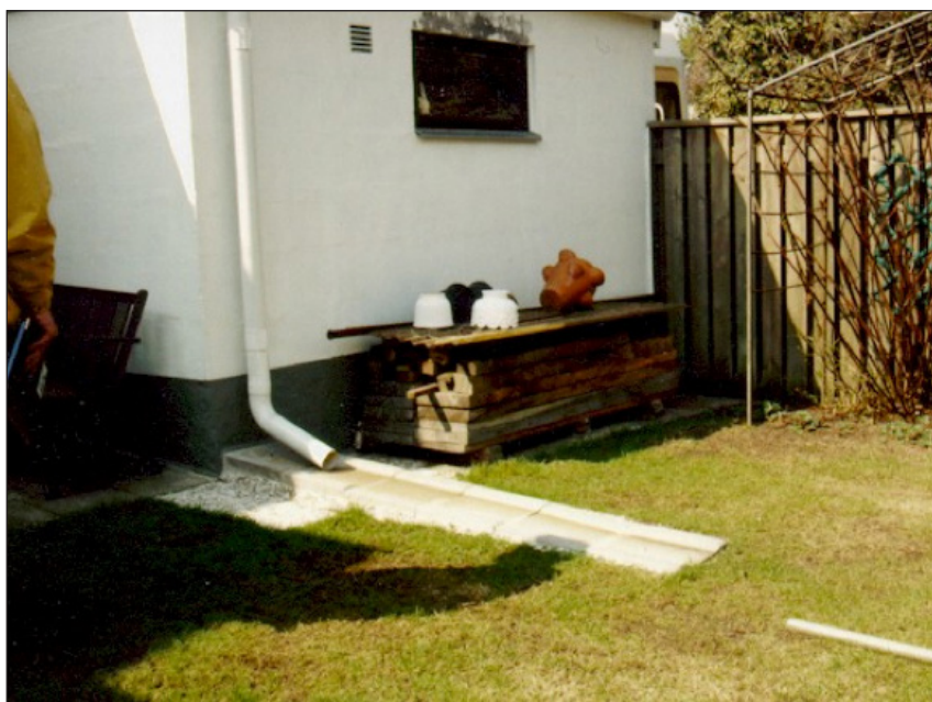
Figur 7-1 Exempel på utkastare med rännal (Sweco 2000).
